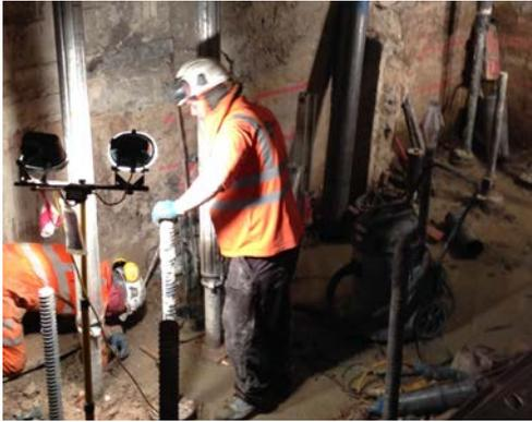
写真 4. 打設が完了したマイクロパイル
